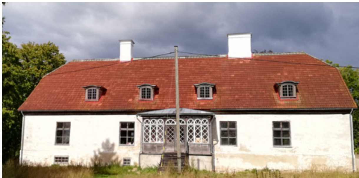
HOONE FASSAAD PÄRAST (NÄHA KORSTNAD JA KATUS)
